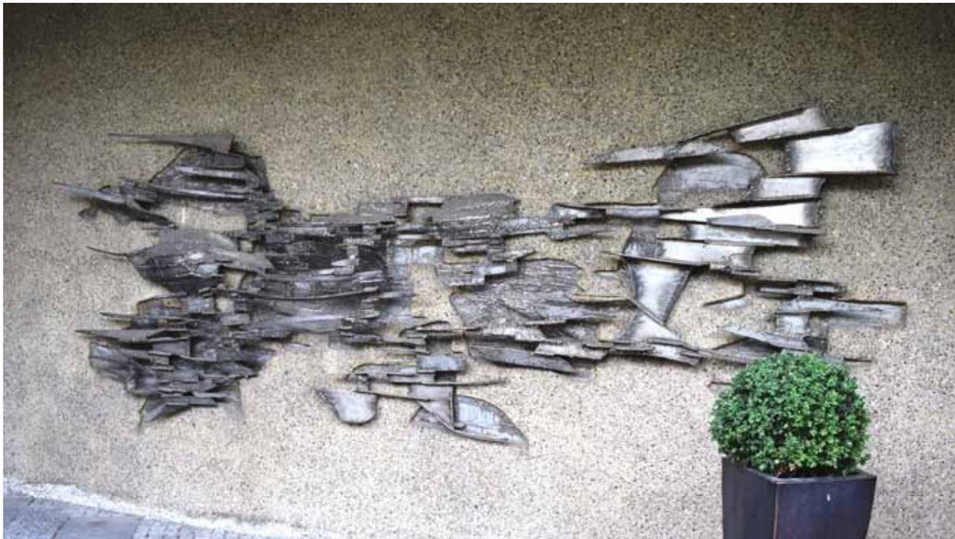
Das Reliefs an der Außenfassade entstand in Teilen vor Ort. Einzelne Werkstücke wurden in den Beton eingegossen, weitere wurden anschließend aufgeschweisst. Es entsteht so der Eindruck des Herauswachsens aus der Wand. Fotos rechts: Stadthalle Braunschweig
